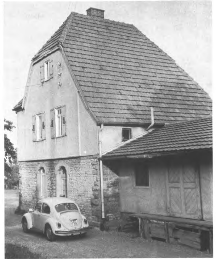
Abb. 5: Die Rückansicht mit dem Hauseingang. Das Sträßchen ist die Zufahrt zum Güterschuppen und zur Laderampe.
