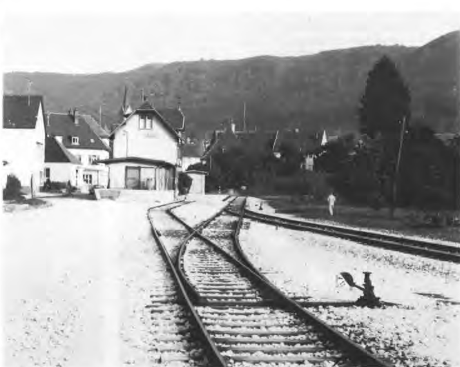
Abb. 5: Bahnhof Gönningen; links Gleis 2 mit Rampe und Güterschuppen, in der Mitte Bahnsteiggleis 1, rechts Gleis 3. Das Güterschuppen-gleis hat keinen Prellbock. Der querliegende Bahnsteig liegt etwa 50 cm über SO und übernimmt diese Funktion. Auch das Hauptgleis ist nur mit einem Signal Sh 2 gesichert.
