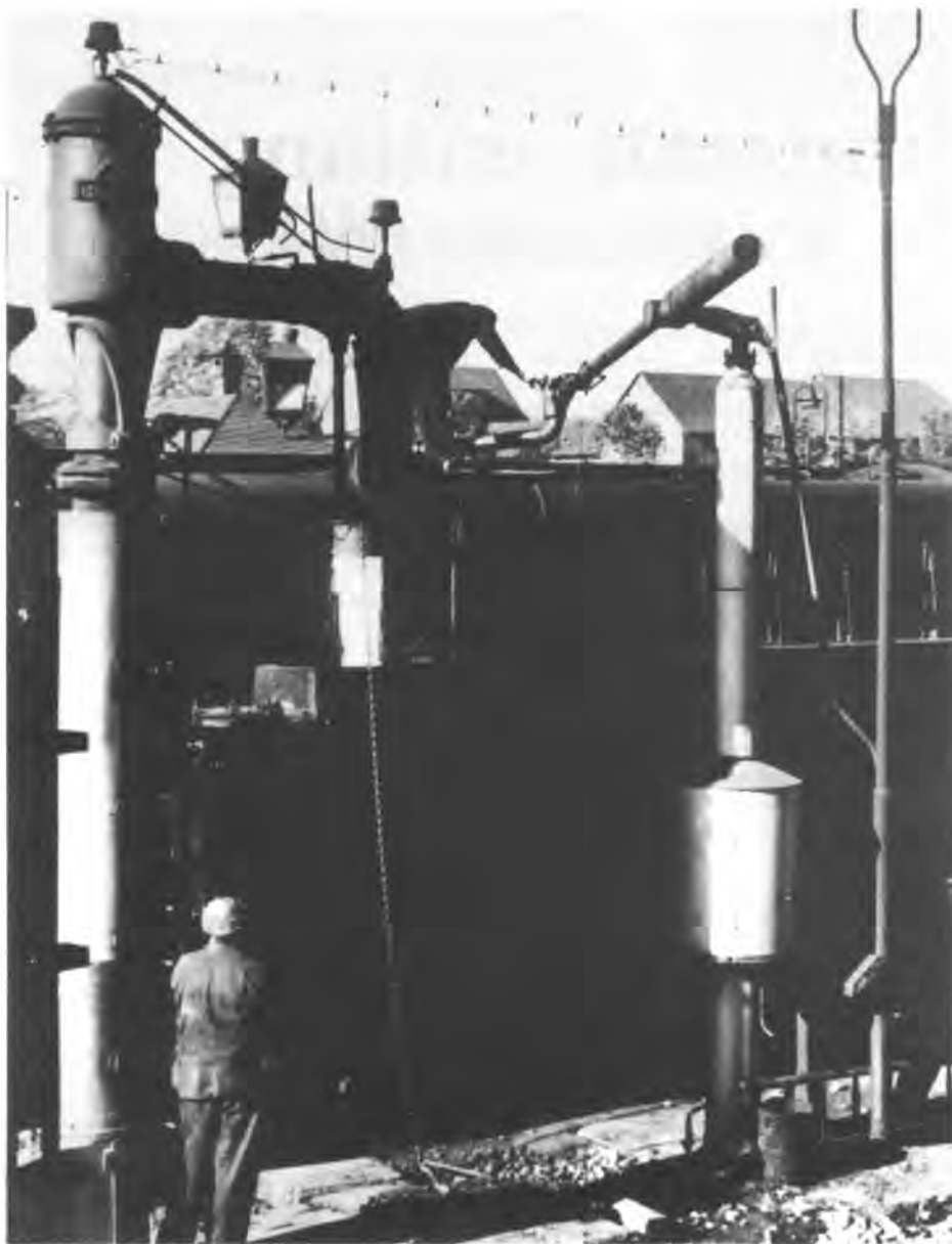
Derselbe Oelkran aus einem anderen Blickwinkel. Wie man auf diesem Foto deutlich erkennen kann, ist das Galgenrohr etwa in der Mitte mit einem weiteren Gelenk versehen, das es erlaubt, das Mundstück millimetergenau über die Einfüllöffnung zu bringen. Foto: Sammlung Kehm
