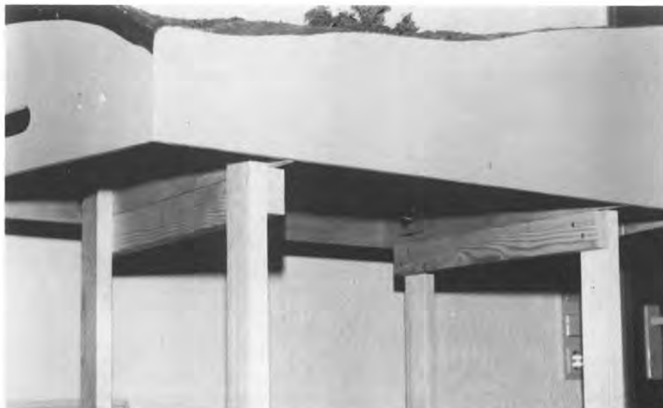
Abb. 4: Anbau des Untergestells an die gebohrten Querspante.
