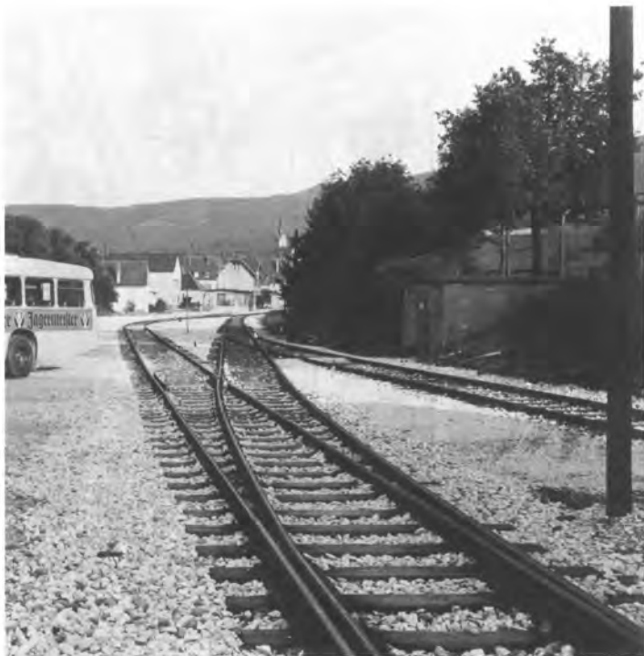
Abb. 8: Bahnhof Gönningen, Blick von Weiche 1 auf Vorfeld und Bahnhof.
